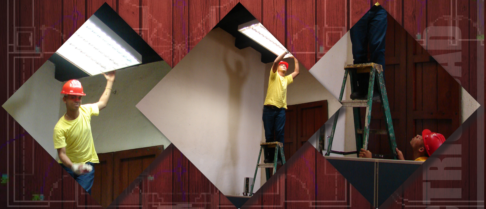
Limpieza de abanicos en área de oficinas
